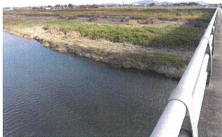
樹木伐採工事施工中（近畿地方整備局発注）
