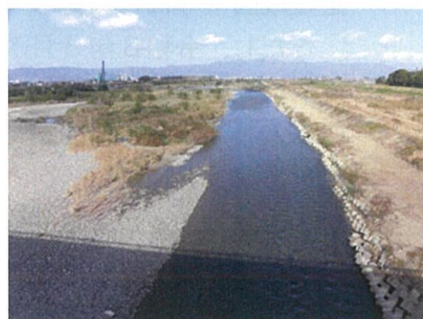
川田大橋右岸側から下流を望む（施工中）
